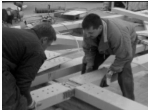
Abb. 3: Klebstoffauftrag und Fügen der Knotenelemente
