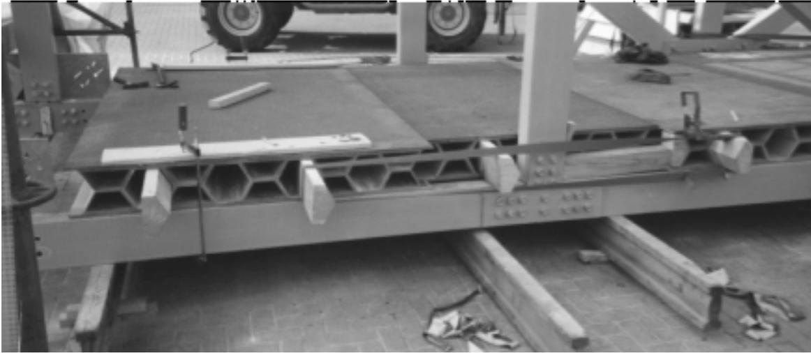
Abb. 9: Fixieren der verklebten Superdeck™ -Elemente
