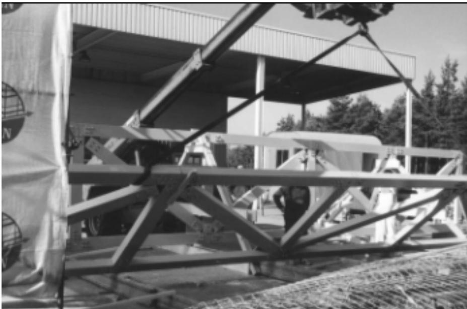
Abb. 4: Aufrichten der fertiggestellten Fachwerke
